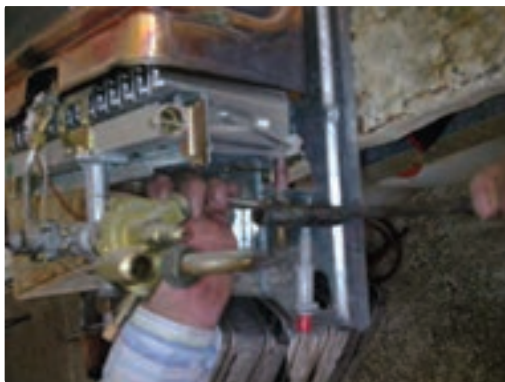
شکل ۸-۱- مبدل گرمایی
