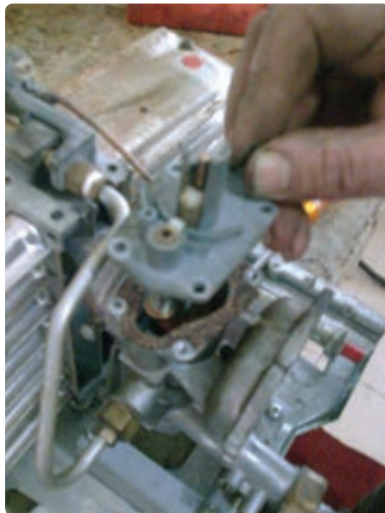
شکل ۱-۲۰-۱ رگولاتور گاز بر روی آب گرم‌کن
