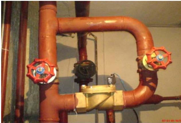
اجرای پروژه شیر برقی
