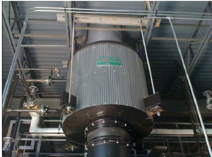
نصب آویز از سقف
