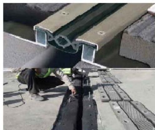
پوشاندن دهانه بالایی درز انقطاع در روی بام ساختمان
