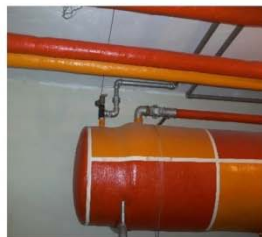
محل قرارگیری سنسور اندازه‌گیری منبع آب گرم مصرفی
