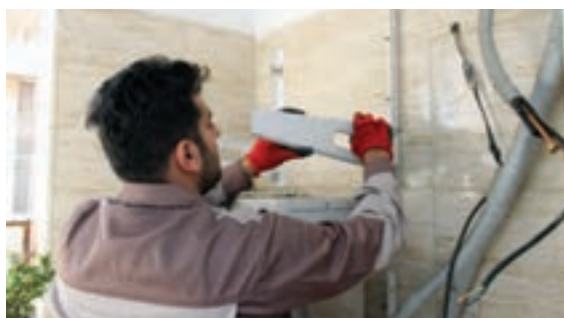
شکل ۷- نصب یونیت خارجی
